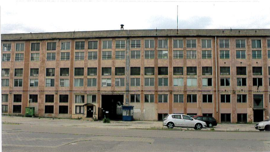
Fot. 1. Elewacja frontowa (północna). 2021
