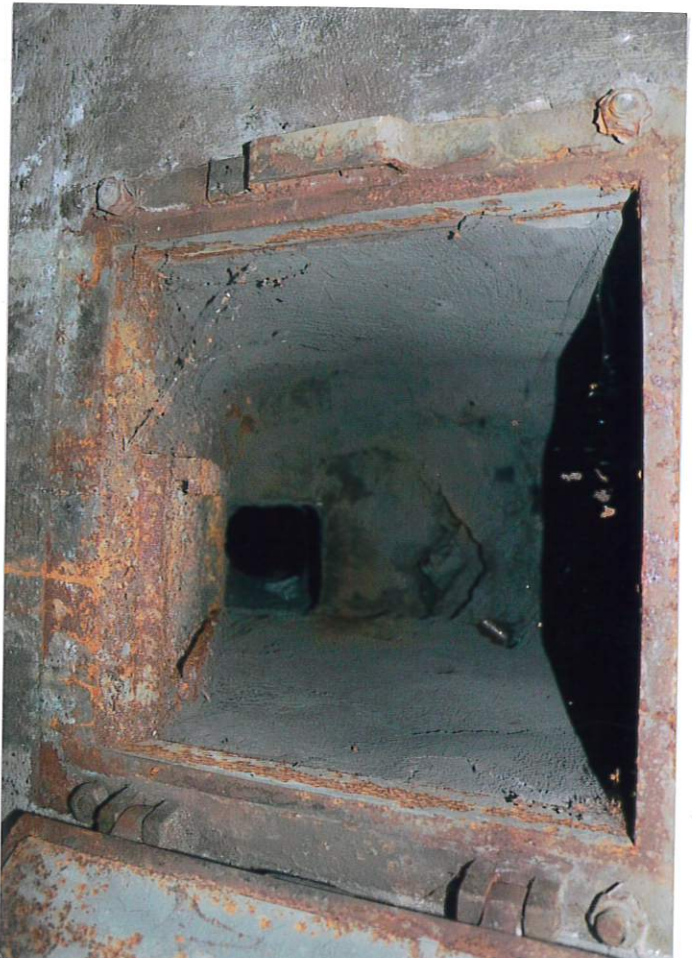
Fot. 11. Otwór strzelniczy /ambrazura w ścianie fundamentowej.
