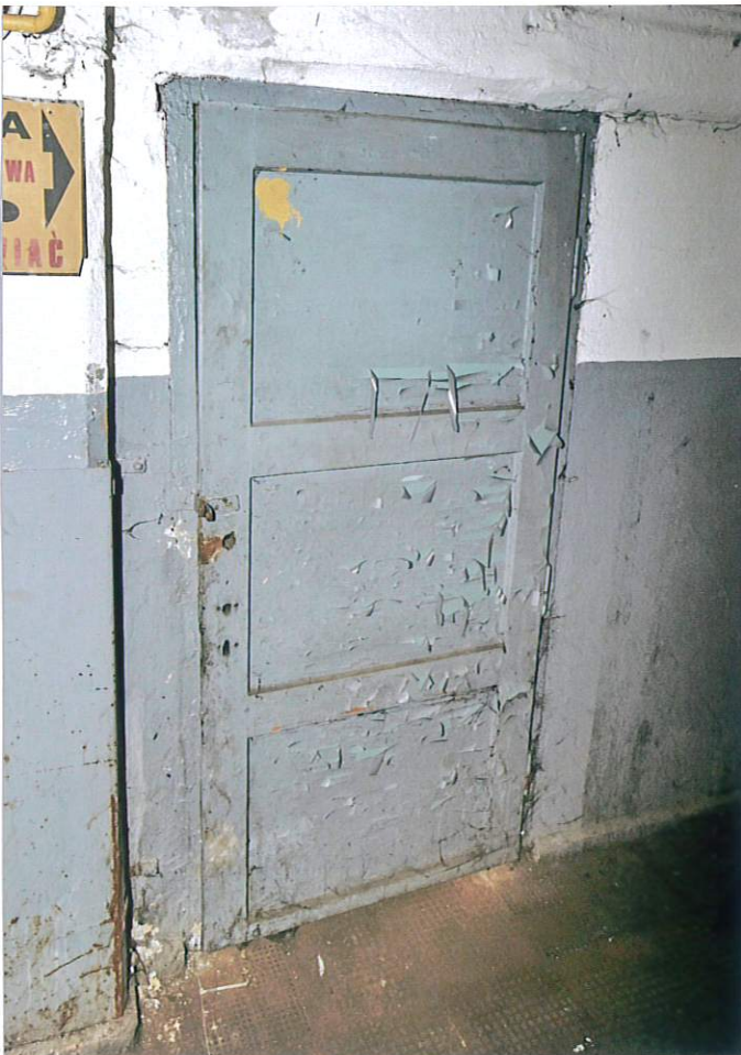
Fot. 16. Powtarzalne drzwi ramowo płytowe
