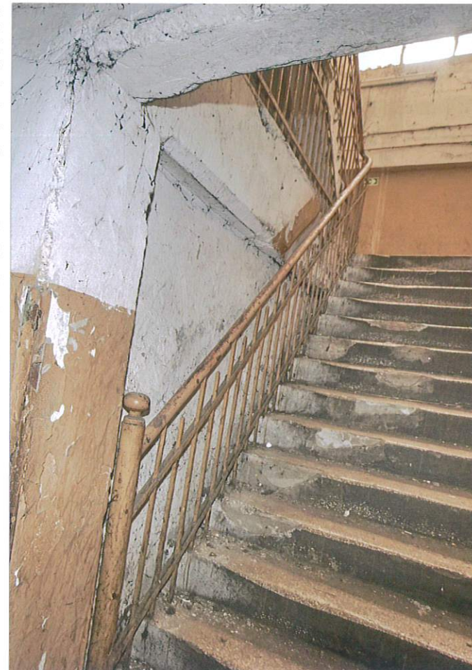
Fot. 14. Balustrada nitowana schodów klatek schodowych
